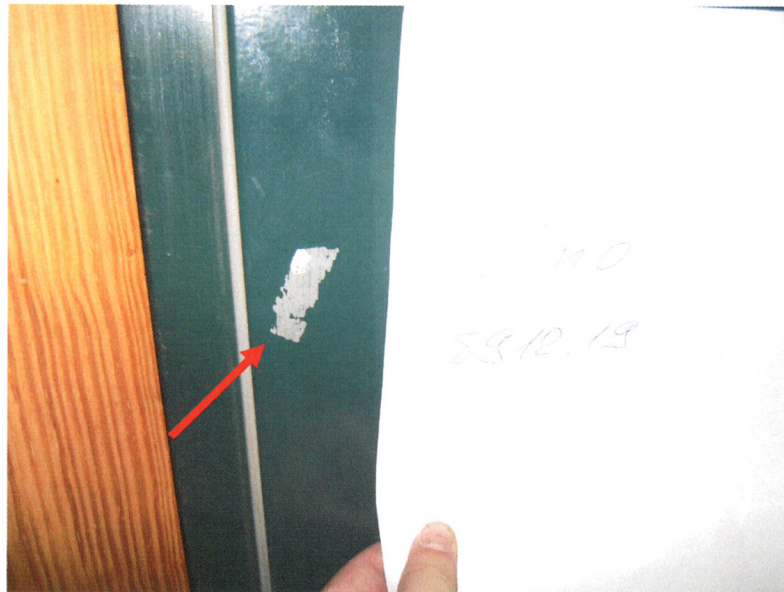
Bild 11: Farbe Türzarge Raum 15 OG
