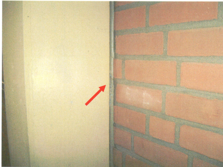
Bild 1: Fugendichtmasse, Stütze/Wand, vor Raum 2, EG
