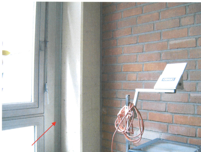
Bild 14: Fugenmasse Fensterrahmen/Wand, Klasse 15 OG
