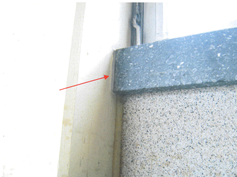
Bild 6: Fugenmasse, Stütze/Fensterbank
