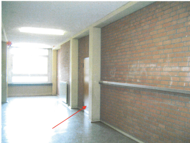
Bild 13: Flurstütze vor Raum 02
