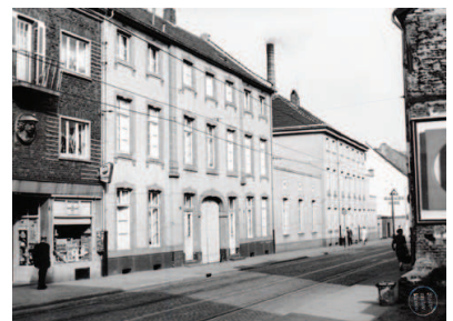
Oberstraße 17-19 vor der Restaurierung, um 1960
