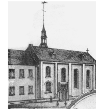
Hospitalkirche an der Westseite der Brückstraße, um 1877
