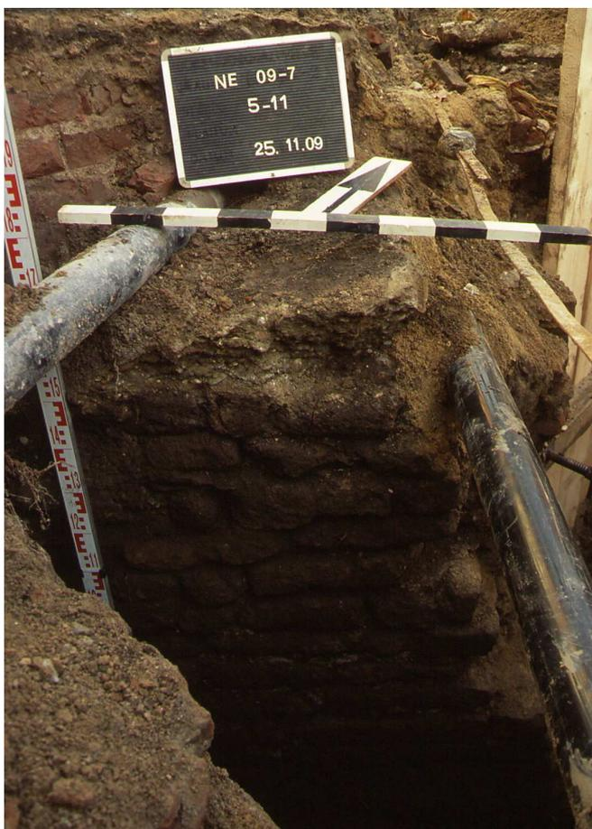
*Kellermauern aus ordentlichem Tuffmauerwerk an der Brückstr. 4, überlagert von Ziegelmauerwerk der Sepulchrinerinnenkirche*
