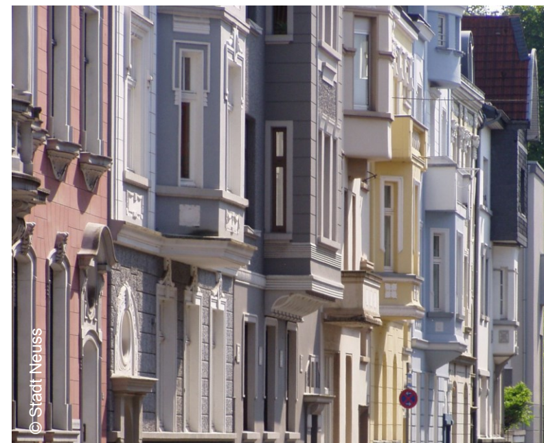
Die Breite Straße in der Stadt Neuss als Beispiel für eine sehr dichte, innerstädtische Bebauung.
